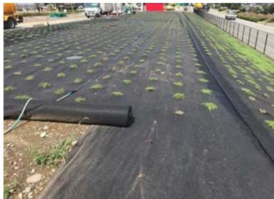
グランドカバープランツ施工の様子
